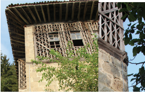
Şekil 21-22. Güneybatı Cephe Detayları
