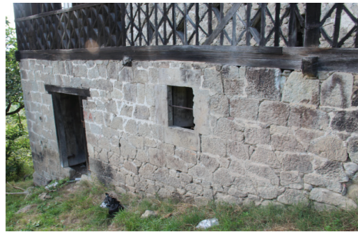
Şekil 13. Güneydoğu Cephesi Bodrum Kat Mevzi Açıklıkları ve Ahşap Kirişler
