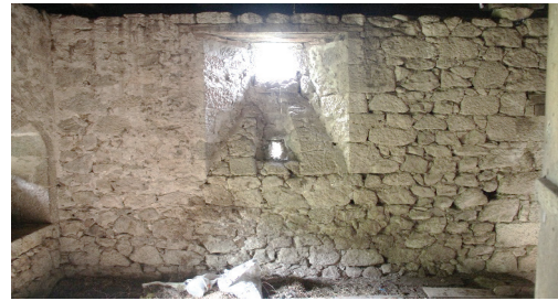
Şekil 36. Bodrum Kat Mazgal Pencere, Altındaki Mevzi Yeri
