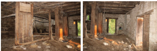
Şekil 32-33. Bodrum Kat İç Mekan Görünüşü
