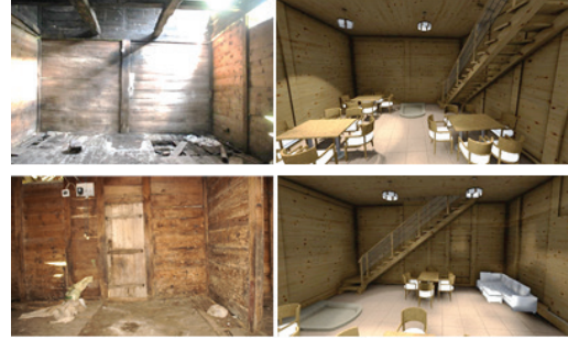
Şekil 78. Restorasyon Öncesi ve Sonrası İç Mekan (Aşhane-Lobi) Görünümleri
