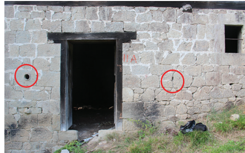
Şekil 13. Güneydoğu Cephesi Bodrum Kat Mevzi Açıklıkları ve Ahşap Kirişler
