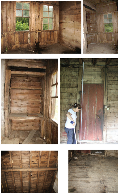
Şekil 55-60. 2 No'lu Odanın Mekânının Özellikleri, Yapı Elemanları
