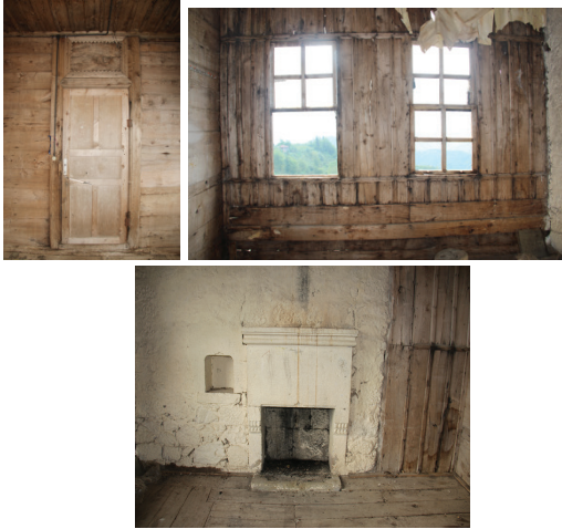
Şekil 61-63 . 3 No'lu Odanın Mekânının Özellikleri, Yapı Elemanları
