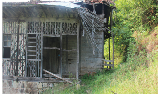
Şekil 12. Güneydoğu Cephesi Bodrum Ahşap Kirişler
