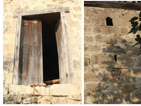
Şekil 23-24. Güneybatı Cephe Detayları
