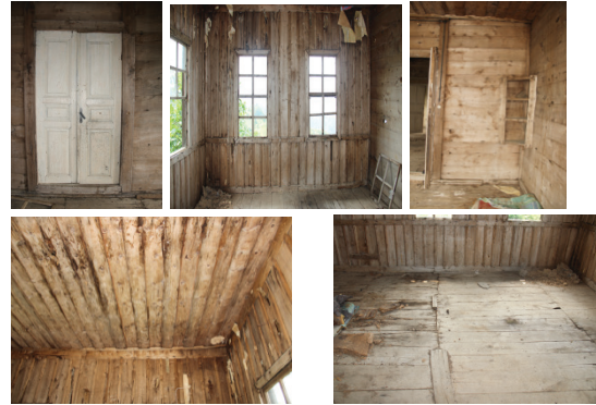
Şekil 50-54. 1 No'lu Odanın Mekânının Özellikleri, Yapı Elemanları
