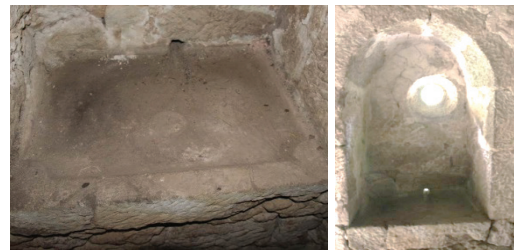
Şekil 37-38. Doğu Duvarındaki Top Deliği ve Abdest Yeri Olan Nişin Görünüşü
