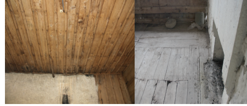
Şekil 64-65. 3 No'lu Odanın Mekânının Özellikleri, Yapı Elemanları
